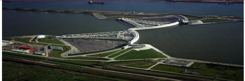
Φράγμα Maeslant, Ολλανδία. Πηγή: www.mimoo.eu/projects/Netherlands
